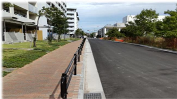
しろやま公園に新設された道路
