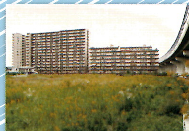
2000.10.5 マルハン建設前空地
