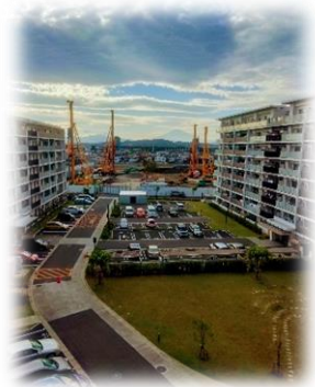
建設が進む新設住宅
