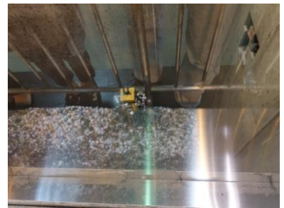
ごみピット。クレーン2基が稼働
