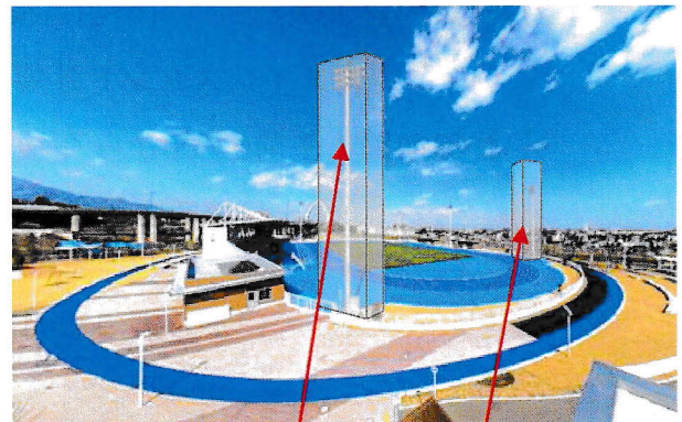
大型照明ポールに足場を設置します
