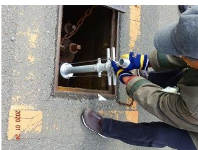
(6) 消火栓のセット。蓋は重い
