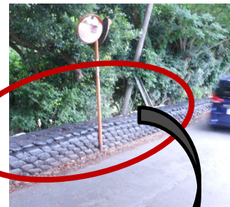
旧堤防の道路上の土嚢
