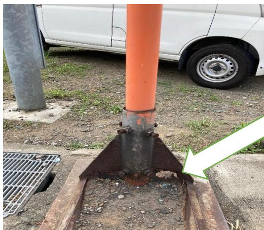
カーブミラーの土台部分が腐食して、穴が開いてあいている状態
