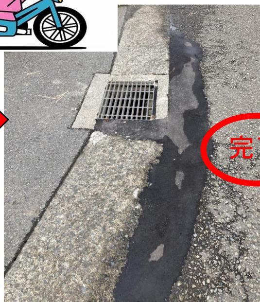
対策・・・側溝の枠を修理して平に修理
